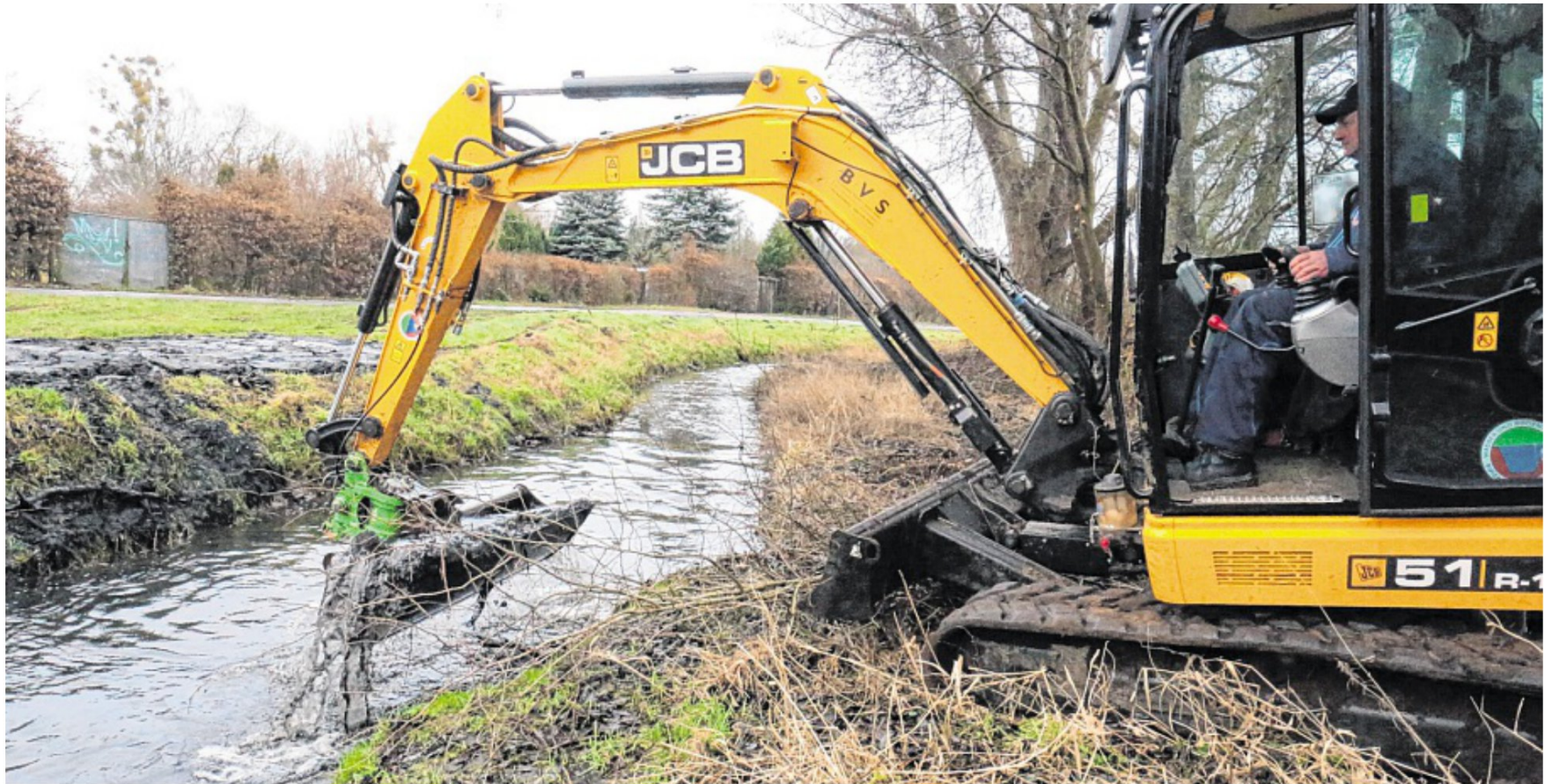
Klein aber für Hagenow sehr wichtig, die Untere Schmaar. Hier räumt Baggerfahrer Jörg Wiechmann den Boden des kleinen Flusses aus.
