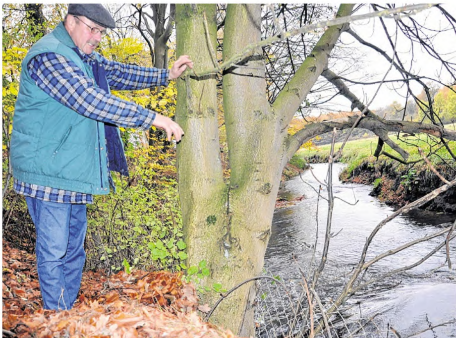
Die Motel nimmt Wilfried Gäbel aus Lehsen Grund und Boden. Die Bäume kippen bald um, der Zaun müsste ein weiteres Mal versetzt werden. Der Verband vertagt die Sanierung.
