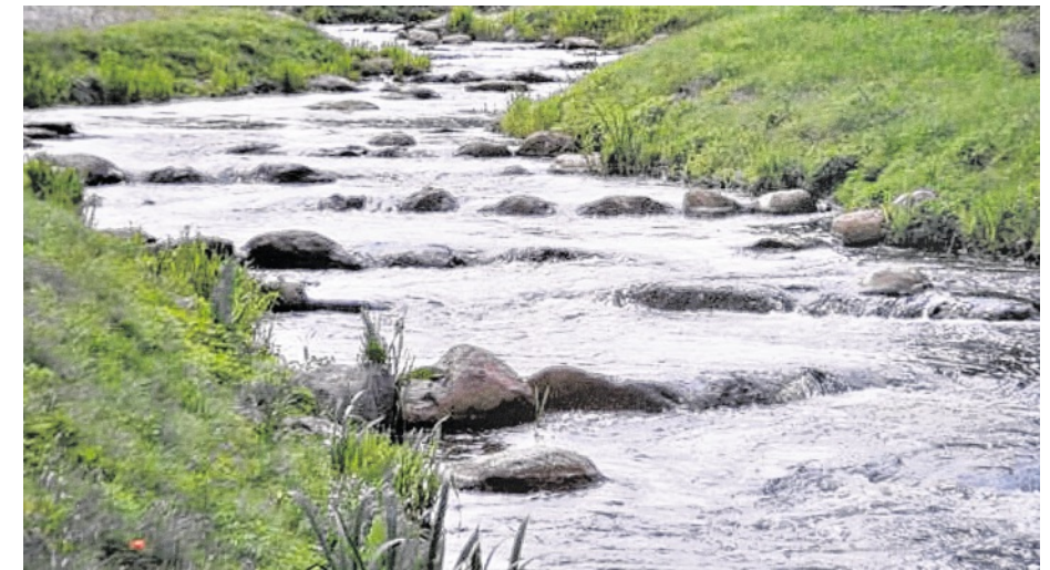
Nachher: Fischaufstiege werden die Stauvorrichtungen im Schwarzen Graben ersetzen. Hier soll Lebensraum für Döbel, Plötzen und Finten geschaffen werden.
