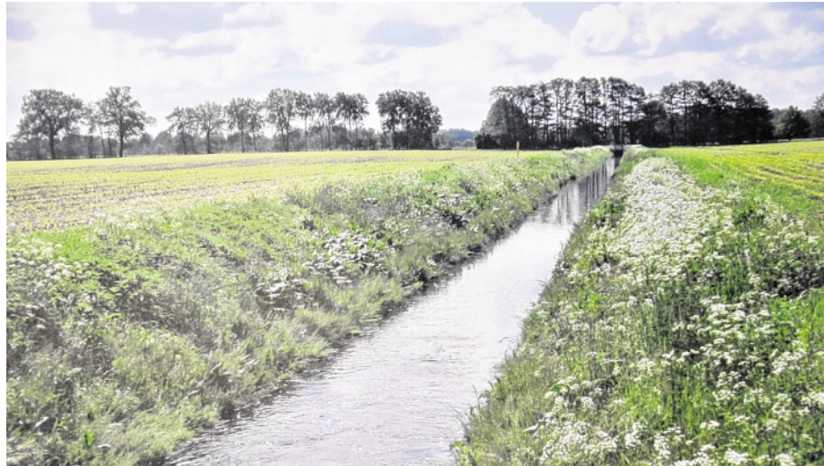
Vorher: Im Schwarzen Graben befinden sich etliche Wehre und Stauvorrichtungen, die im Zuge des Ausbaus verschwinden sollen.
