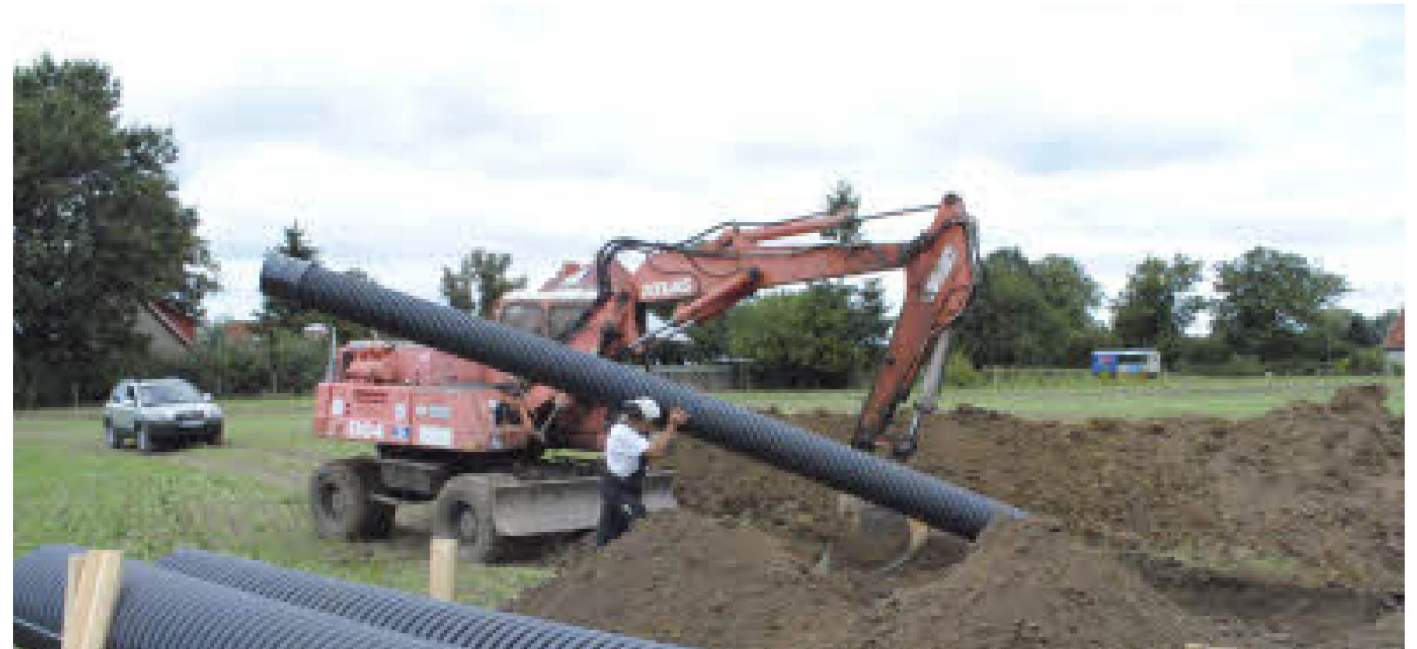
Bei Tessin erneuert der Wasser- und Bodenverbandes „Boize-Sude-Schaale“ eine marode Entwässerungsleitung. FOTO: HIRSCHMANN
