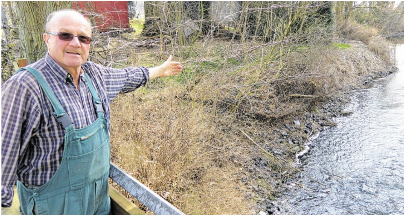
Früher habe es hier zwei Eisvogelpärchen gegeben. Die seien längst weg, weil sie hier keine Bruthöhlen mehr graben könnten. Auch Forellen seien verschwunden, moniert Wilfried Gäbel und zeigt auf die Motel-Uferabbrüche hinter seinem Haus. FOTOS: THORSTEN MEIER
