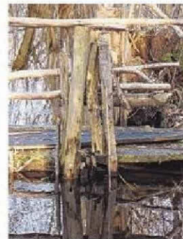
Vor den Arbeiten hatte der Bach einen hohen Wasserstand, ...
