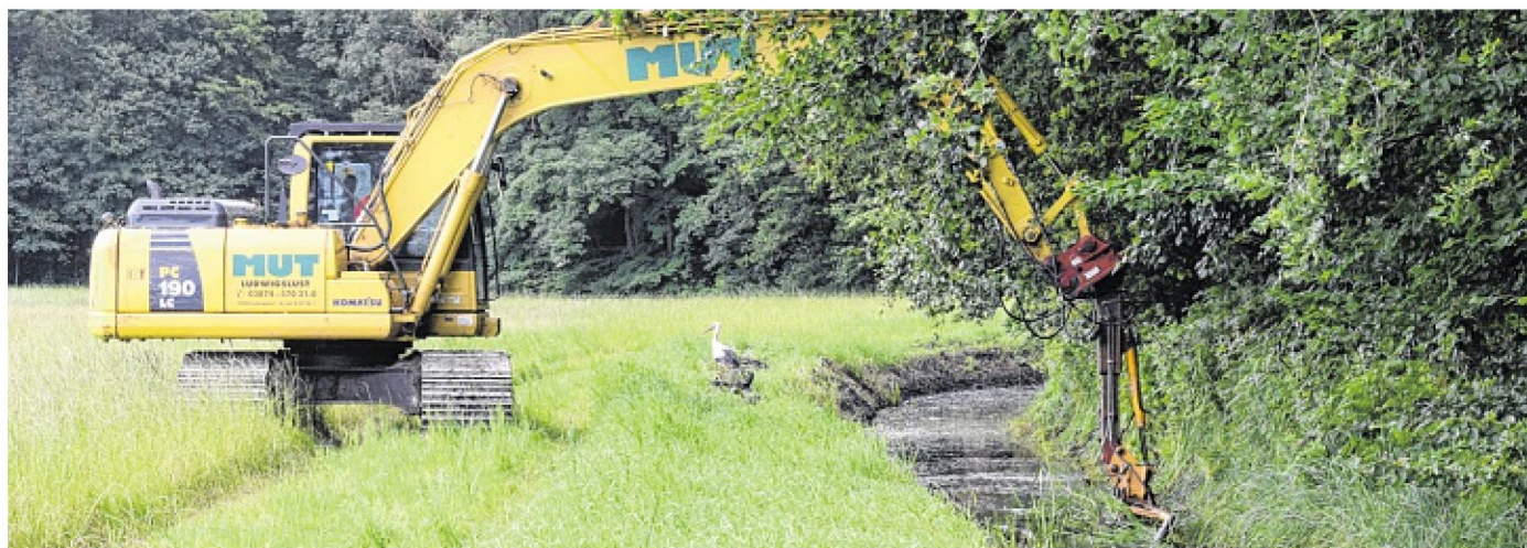
Guido Dormann befreit die Gräben von Bewachungen, damit das Oberflächenwasser besser abfließen kann. Mit dabei ist Adebar, der aufmerksam jede Bewegung des Baggerarmes beäugt, ob etwas Futter für ihn dabei ist.
