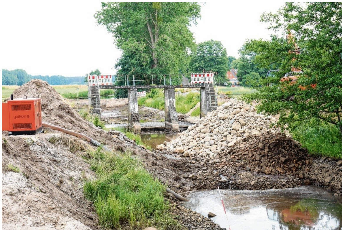
WASSERBAUSTELLE NAHE KUHSTORF, HIER FLIESST SONST EIGENTLICH DIE SUDE LANG. JETZT ENTSTEHT HIER EINER FISCHAUFSTIEGSANLAGE. POHLE
