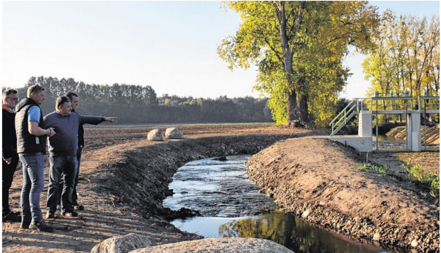
Die vorläufige Bauabnahme: In zwei Wochen soll die Maßnahme beendet und das Wehr an die Gemeinde übergeben werden. FOTO: ROLE
