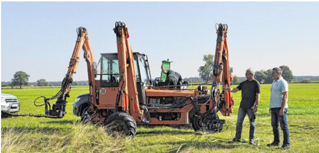
Einsatz eines Balkenmähers im Auftrag des Wasser- und Bodenverbandes nahe Gothmann bei Boizenburg im Jahre 2016. Es geht darum, die Gewässer fließfähig zu halten.
