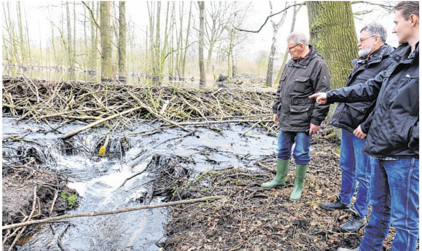
Der Biberdamm am Mühlenbach nahe Schwanheide: Bürgermeister Gerd Altenburg sowie Andreas Schwebs und Steffen Wagner (v.li) vom Wasser- und Bodenverband begutachten das meisterliche Bauwerk mit Sorge. FOTO: MAYK POHLE
