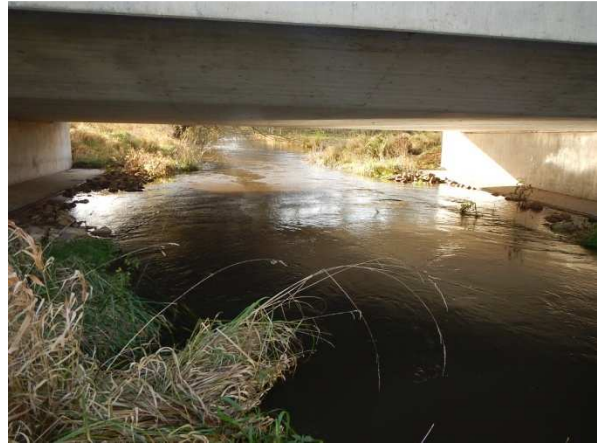
Abbildung 3.11: Straßenbrücke der B 5 über die Sude bei Station 39+326
