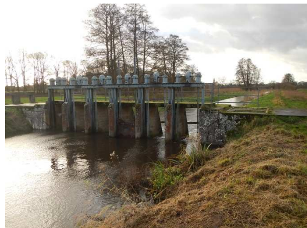
Abbildung 3.9: Sudewehr (Wehr Redefin oberhalb B5) bei Station 40+186
