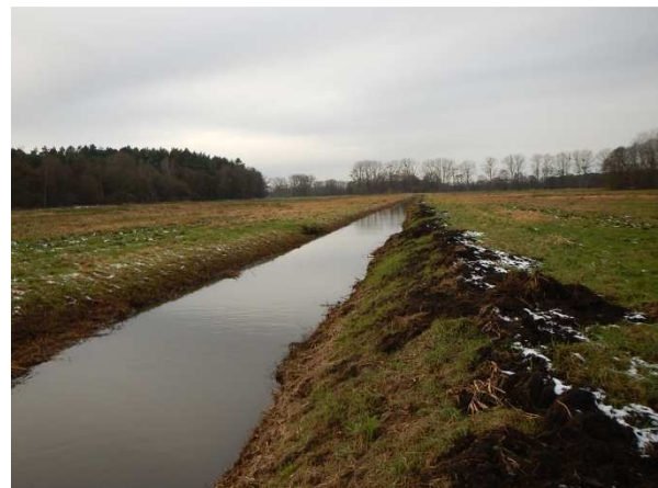
Abbildung 3.13: Unterhaltenes Regelprofil des Bresegarder Mühlenbachs bei Station 1+015
