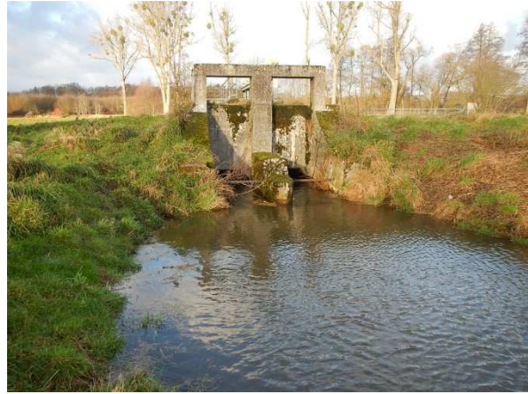
Abbildung 3.15: Dükereinlauf des Bresegarder Mühlenbachs unter der Sude mit vorgelagerter Grundschwelle bei Station 0+146
