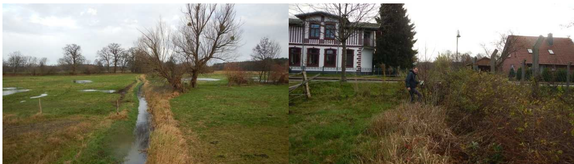
Abbildung 5.8: Parallelgraben der Sude (L743_00_2) und Abschlagsgraben zum Burgwall im Bereich Schulweg (rechts)
